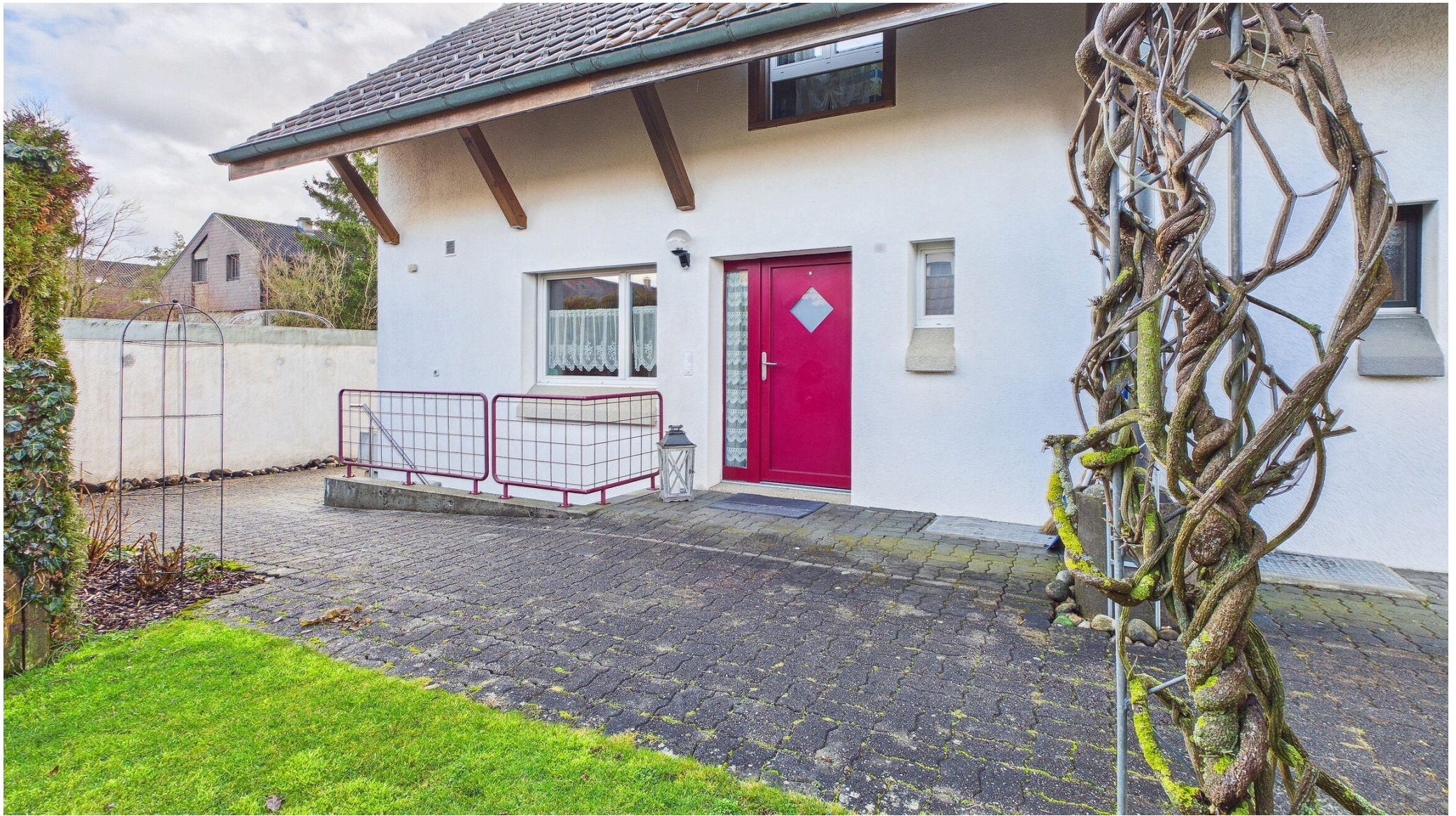
Zugang/Eingang EG sowie Aussentreppe ins UG
