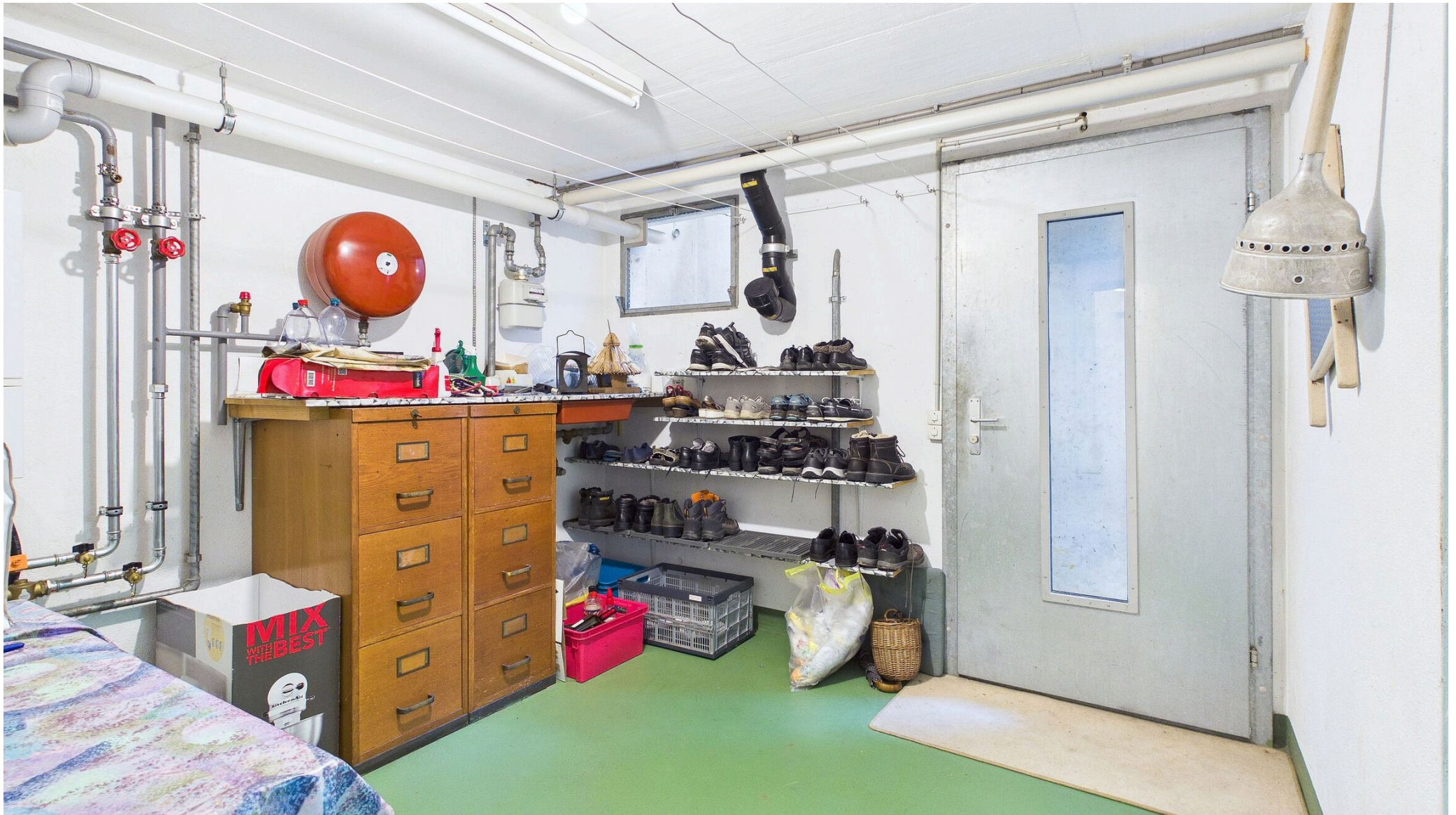
Allzweckraum UG mit Aussenzugang
