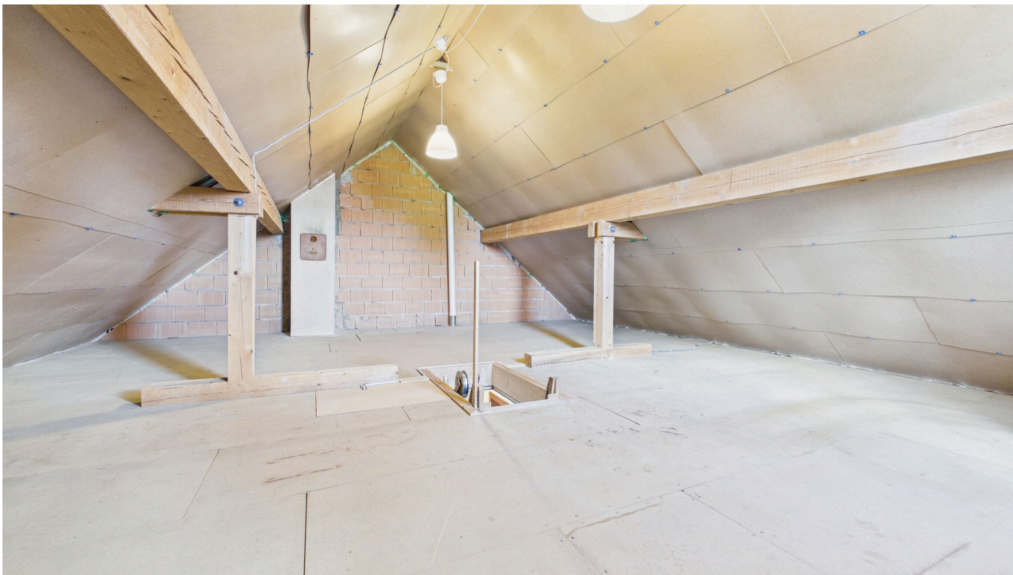
Estrich, ausbaubar zu Wohnzwecken
