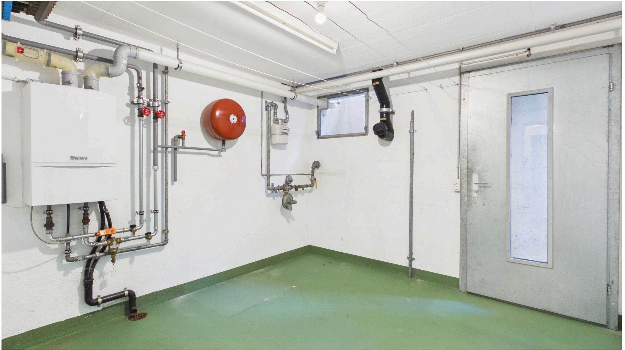
Allzweckraum UG mit Aussenzugang
