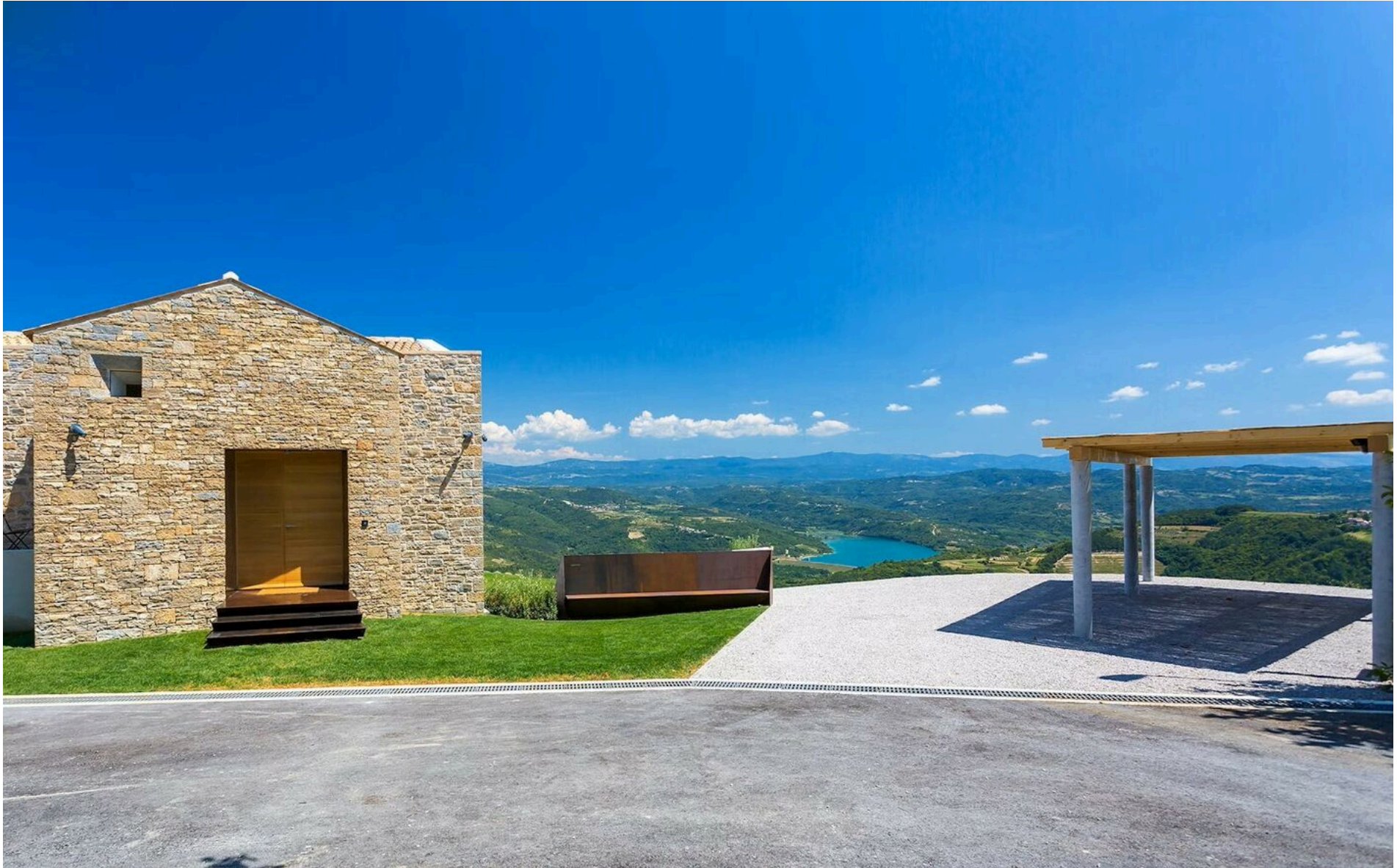
Zufahrt mit Carport
