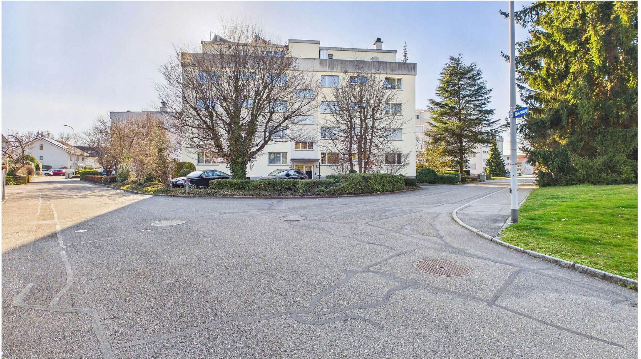
Ansicht MFH Eigerweg 8 (Nordost)
