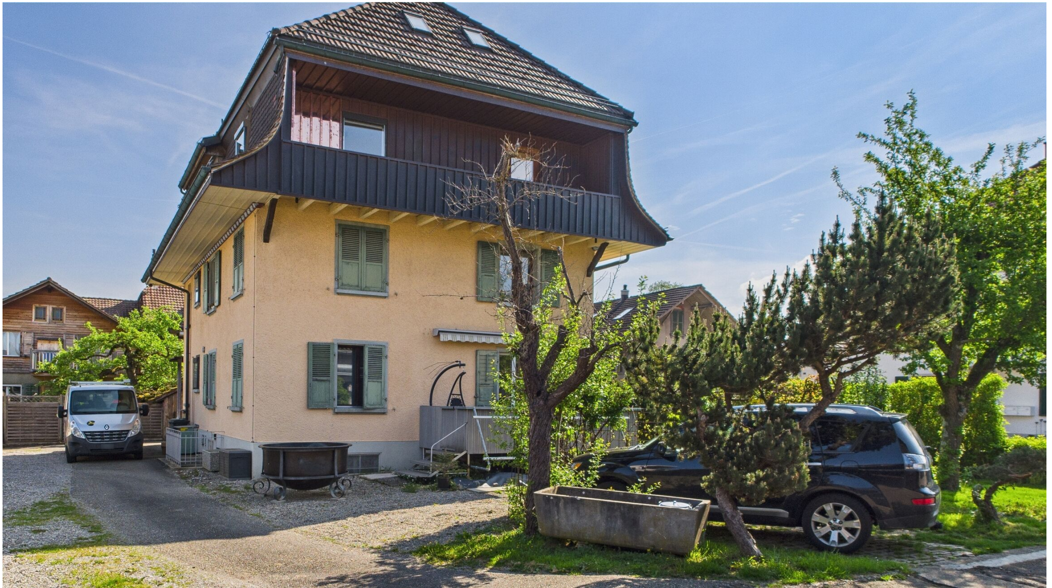
Balkon Hochparterre (Westausrichtung)
