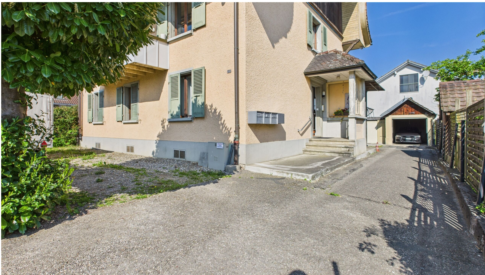
Zugang zu der Wohnung im Hochparterre
