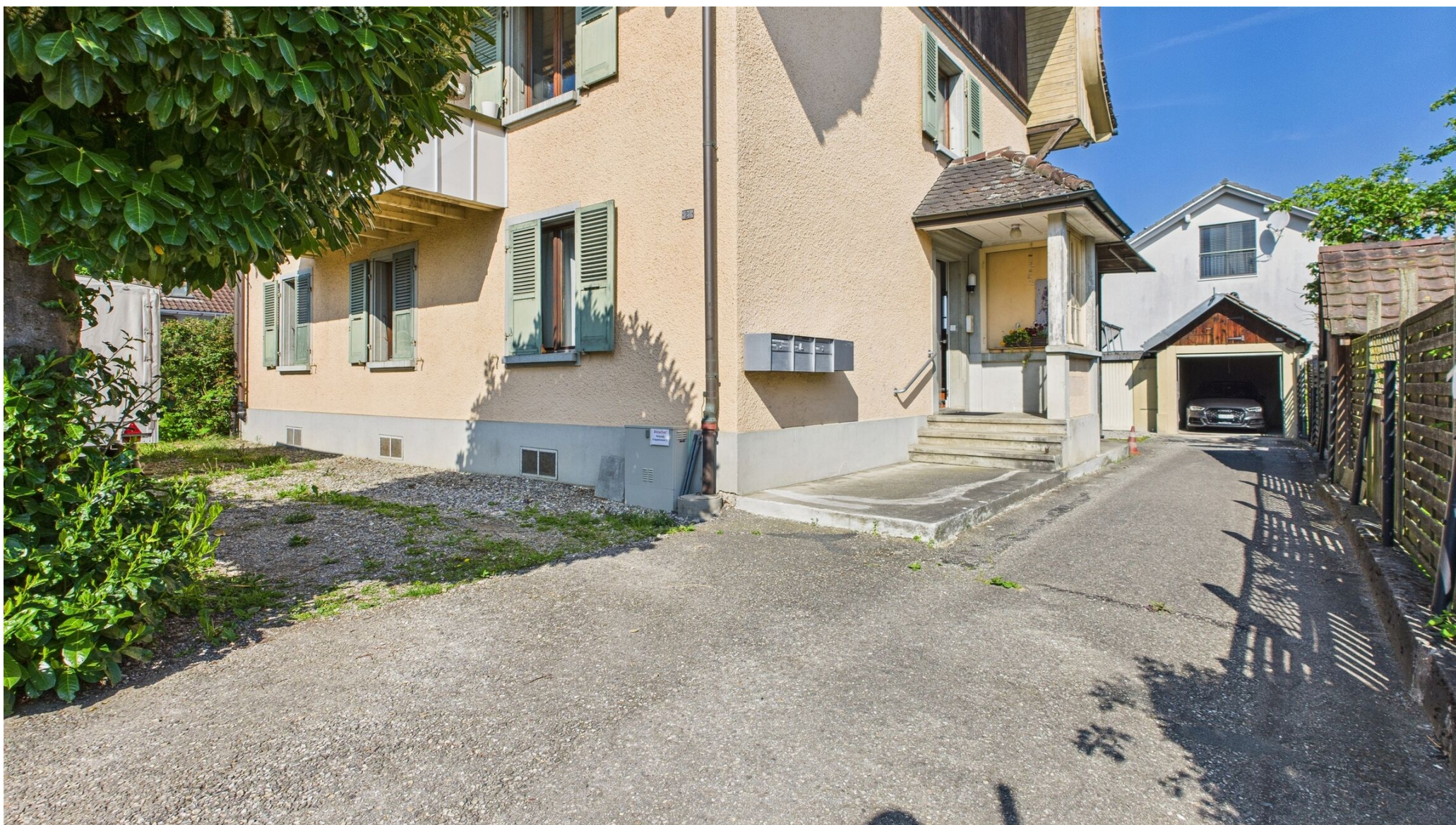
Zugang zu der Wohnung im Hochparterre
