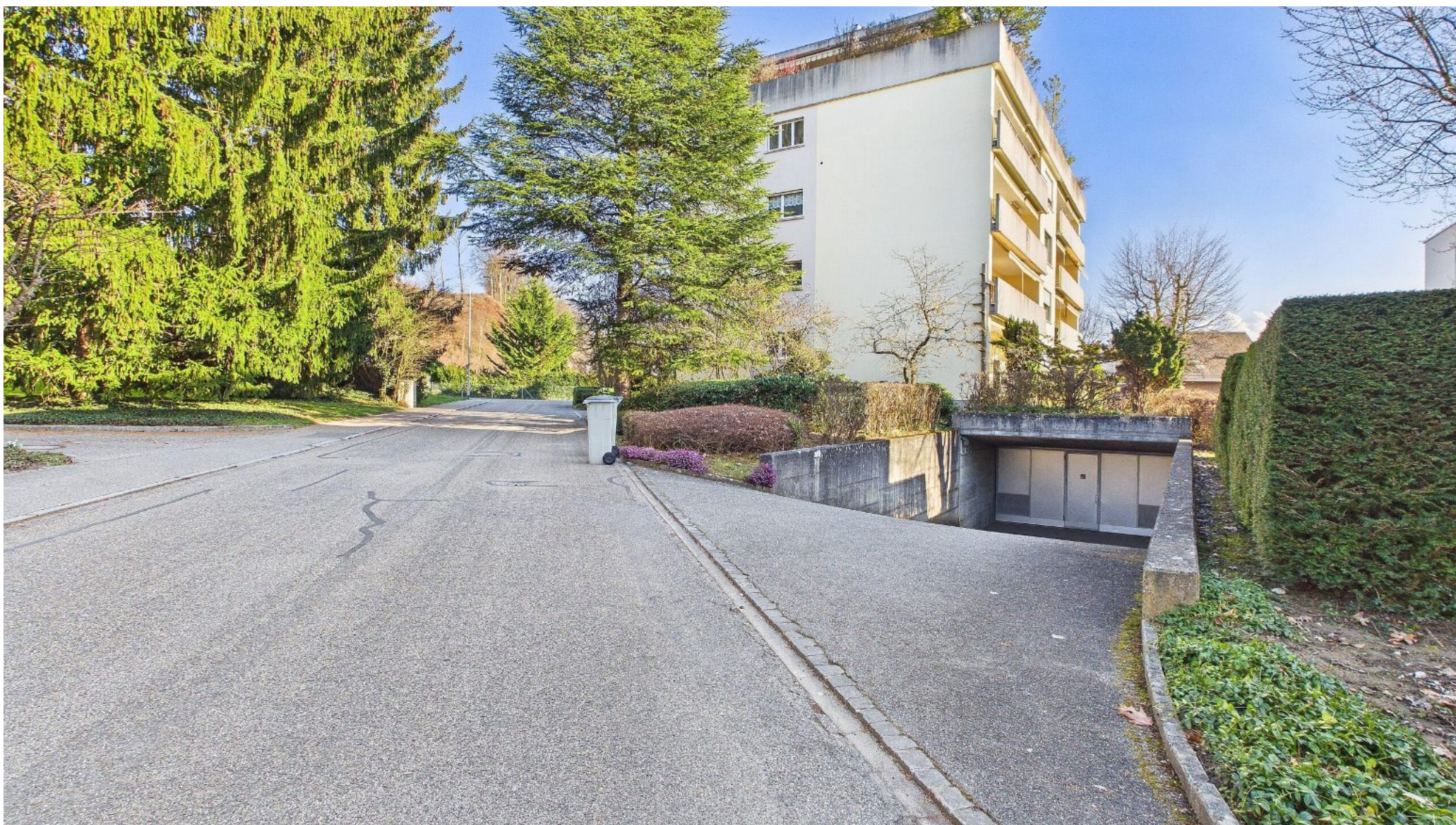
Zufahrt in die Einstellhalle
