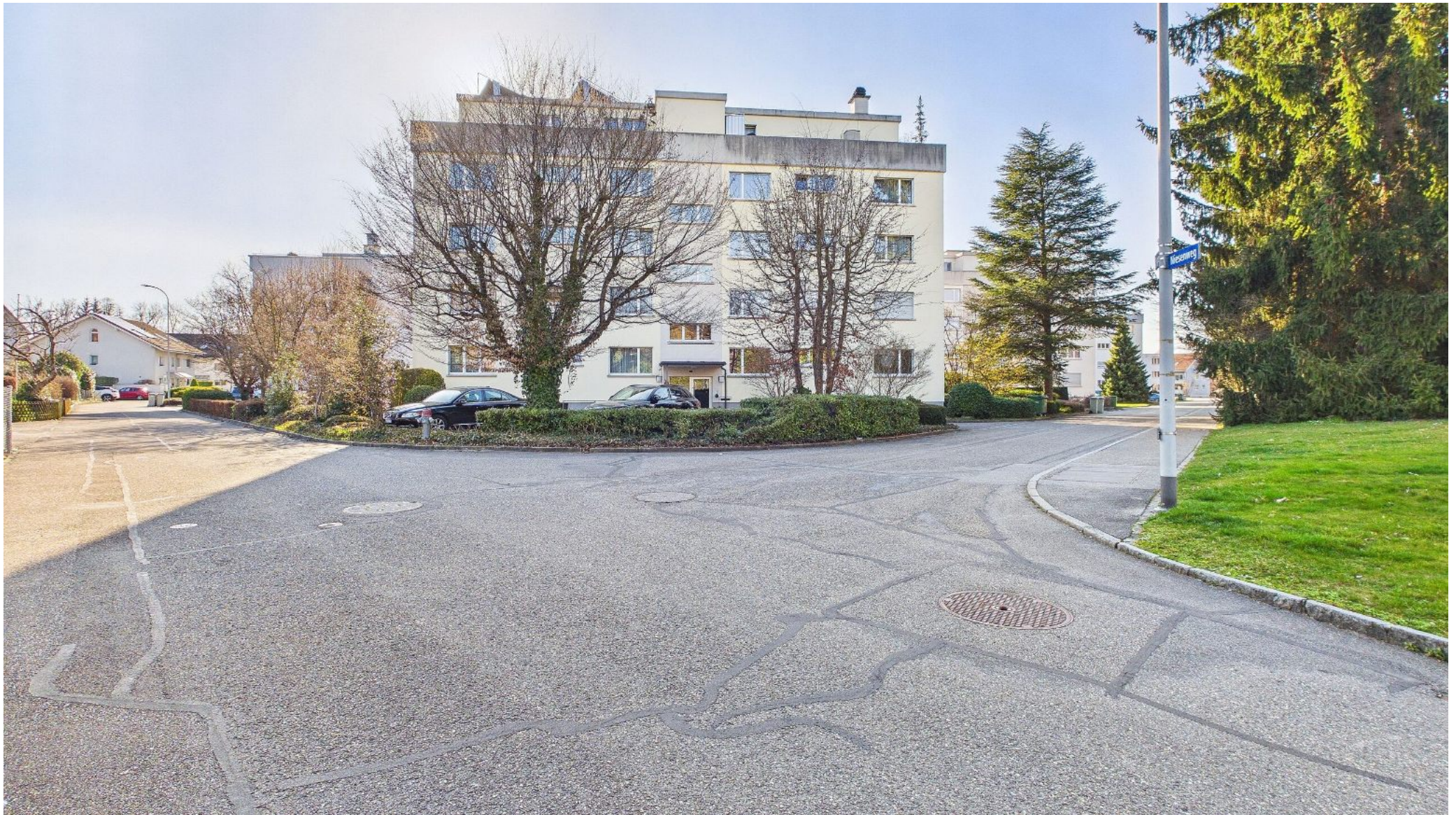
Ansicht MFH Eigerweg 8 (Nordost)
