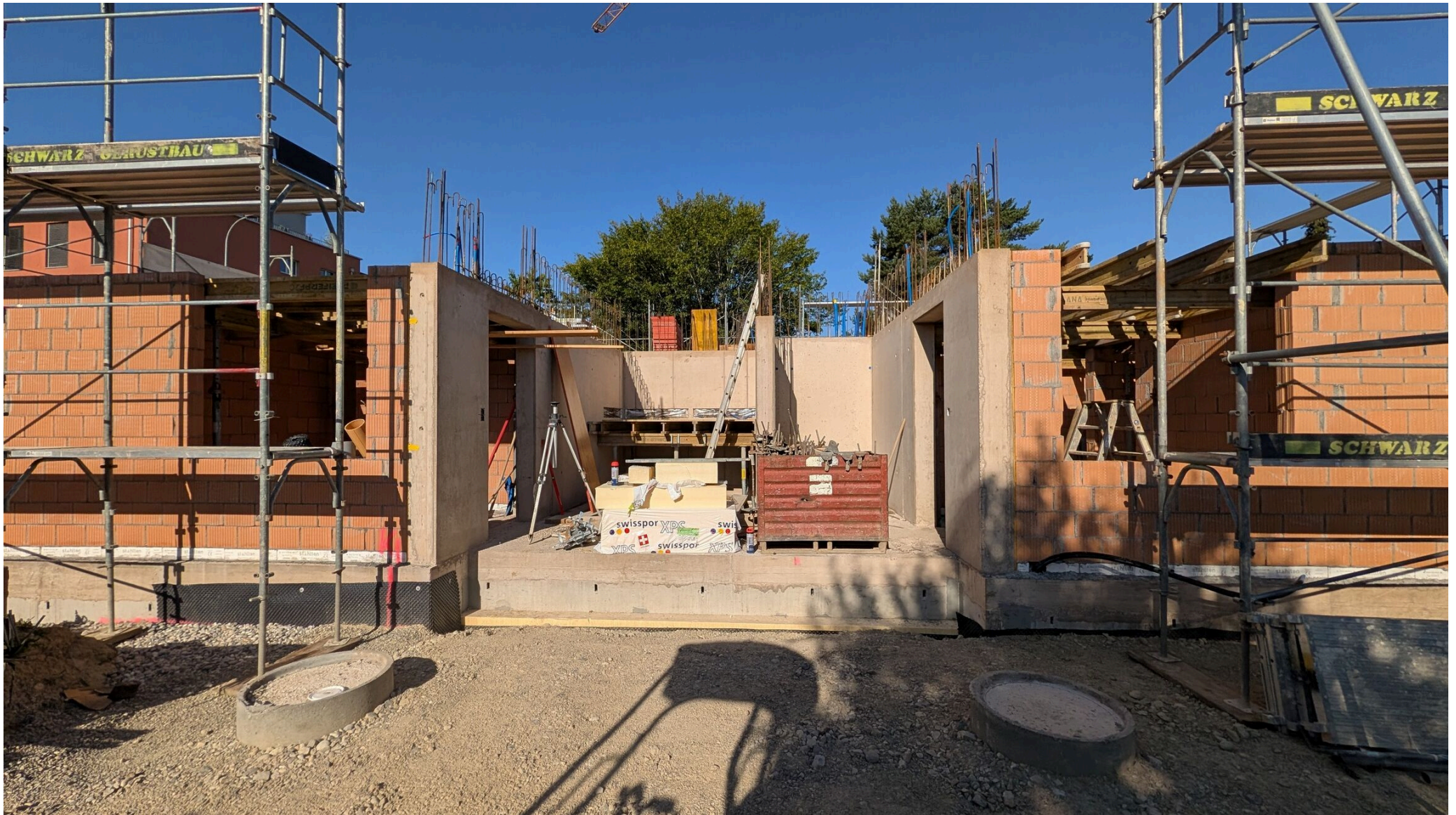
Eingangsbereich (Ost) mit Treppe und Lift
