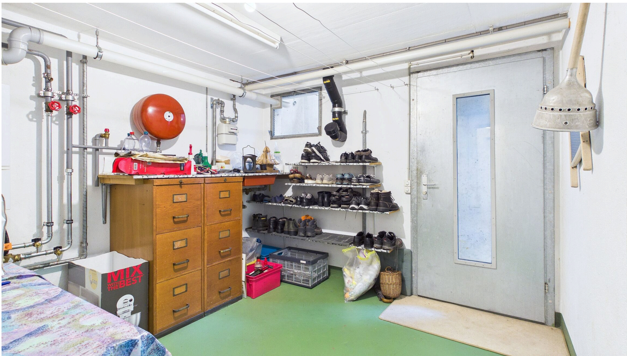
Allzweckraum UG mit Aussenzugang
