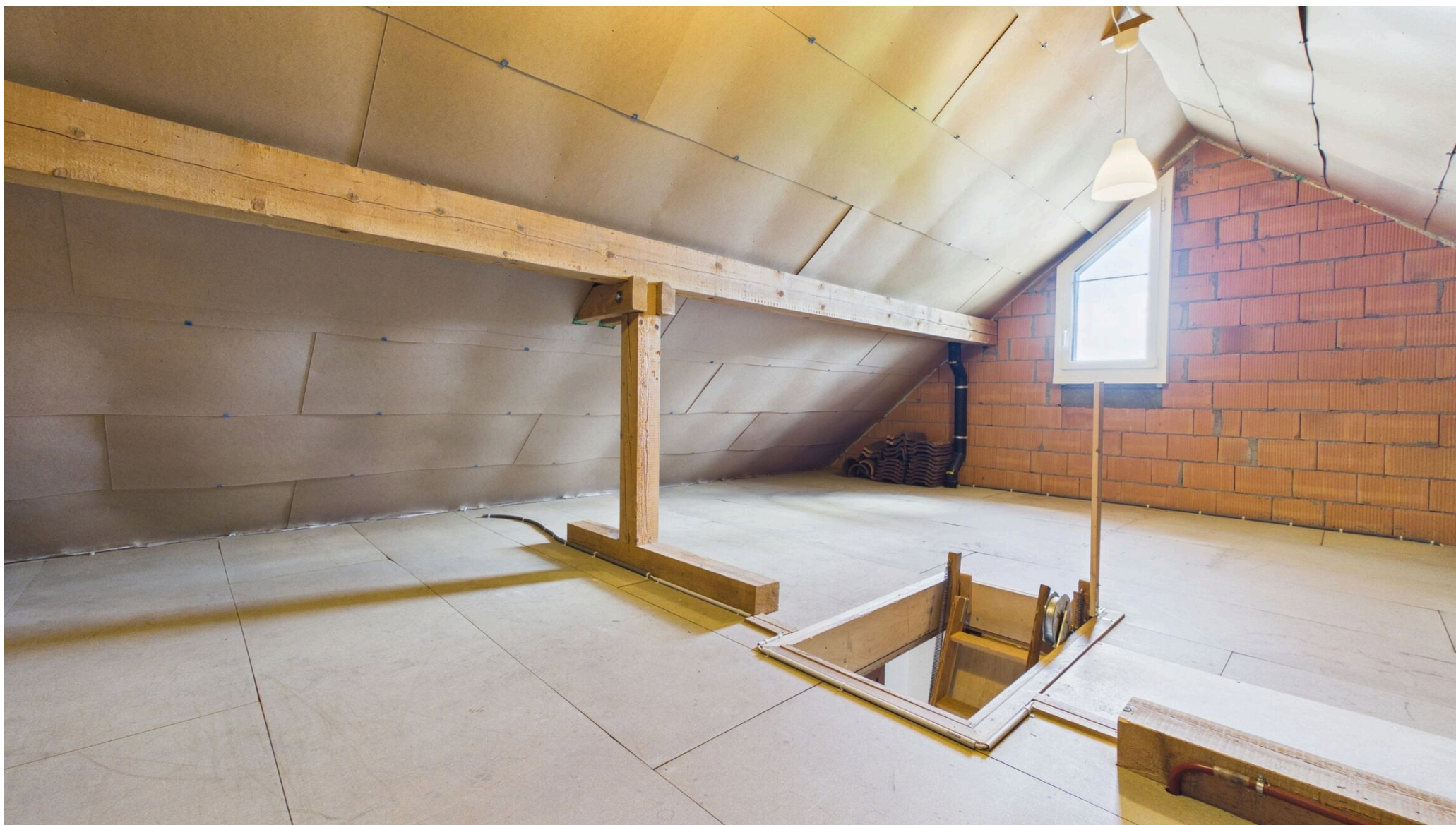
Estrich, ausbaubar zu Wohnzwecken
