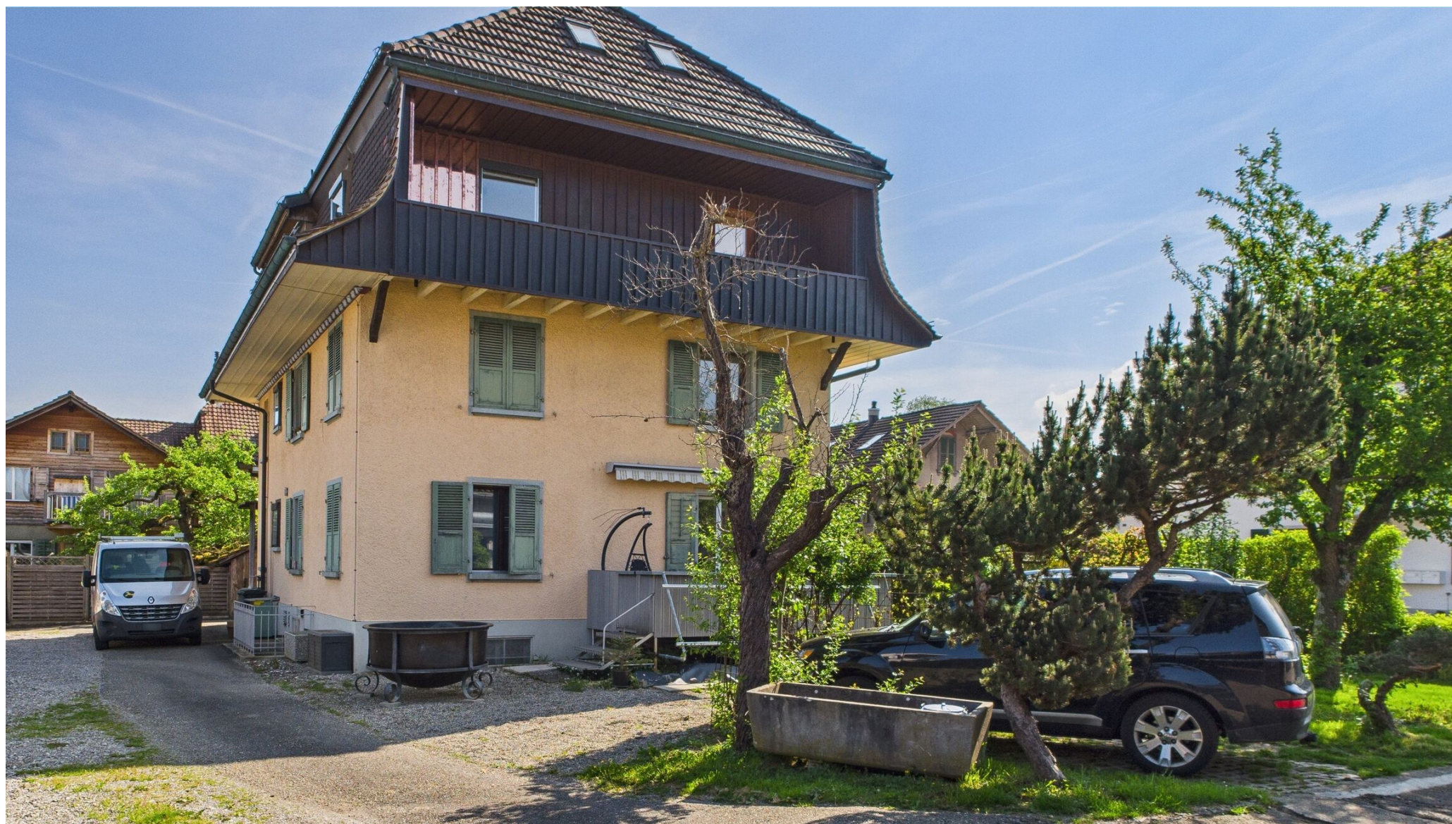
Balkon Hochparterre (Westausrichtung)
