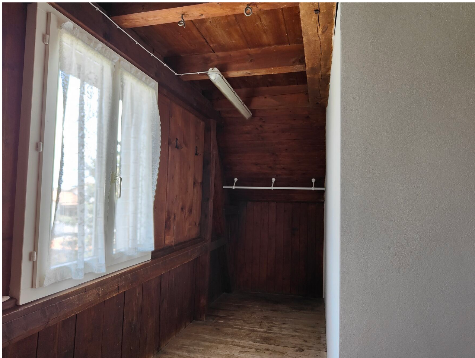
Redit vor der Eingangstüre
