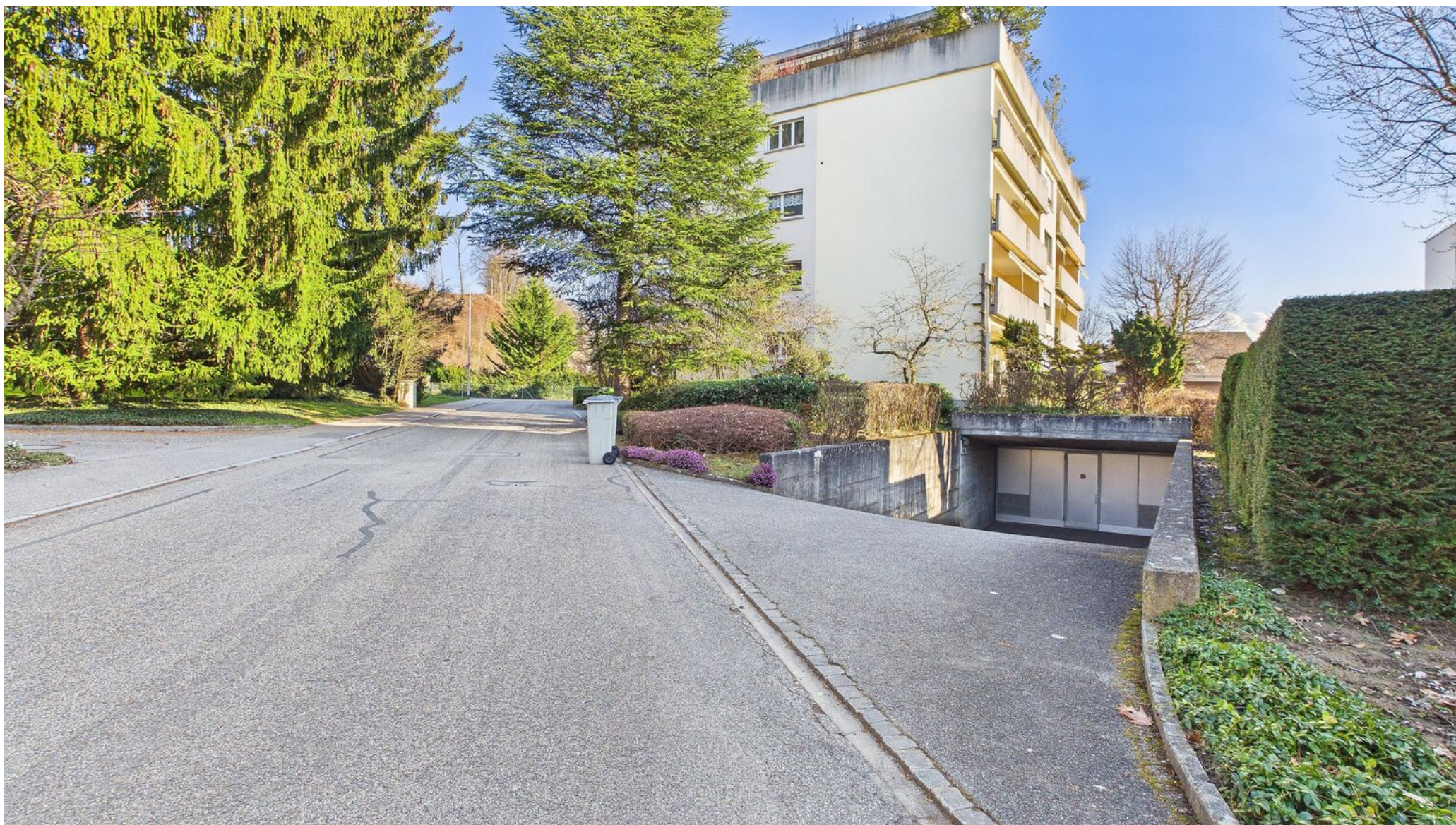
Zufahrt in die Einstellhalle
