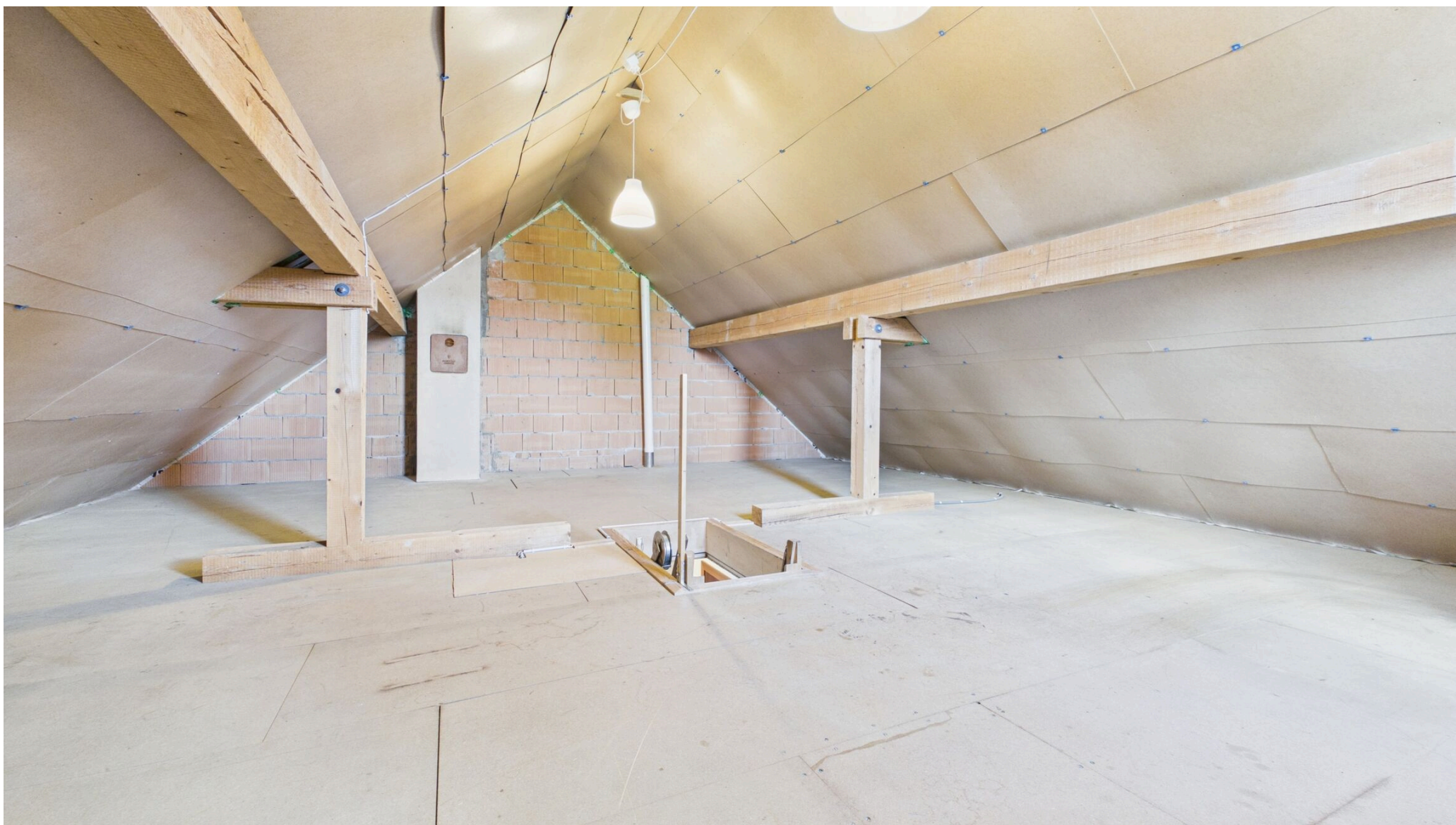
Estrich, ausbaubar zu Wohnzwecken
