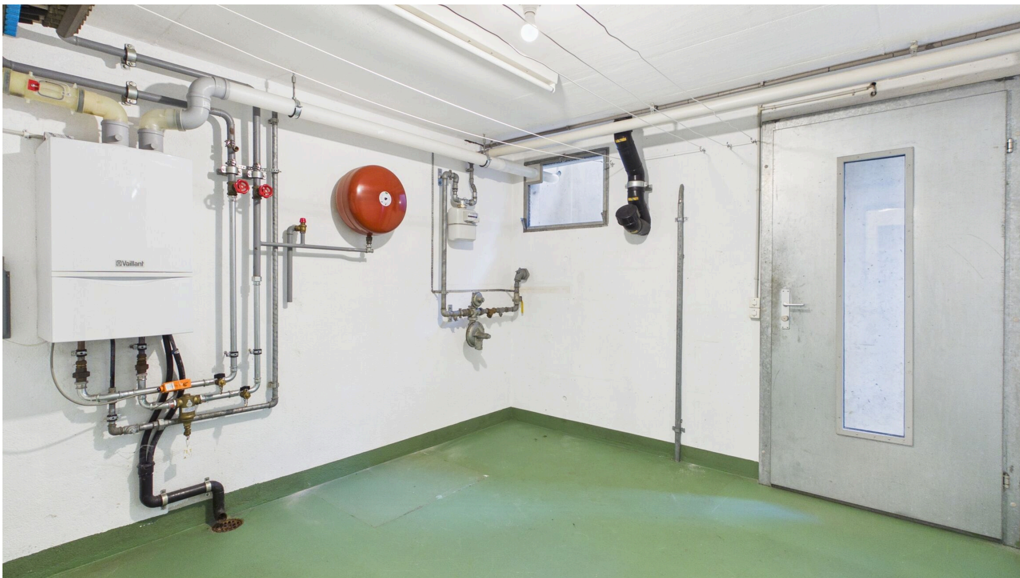
Allzweckraum UG mit Aussenzugang
