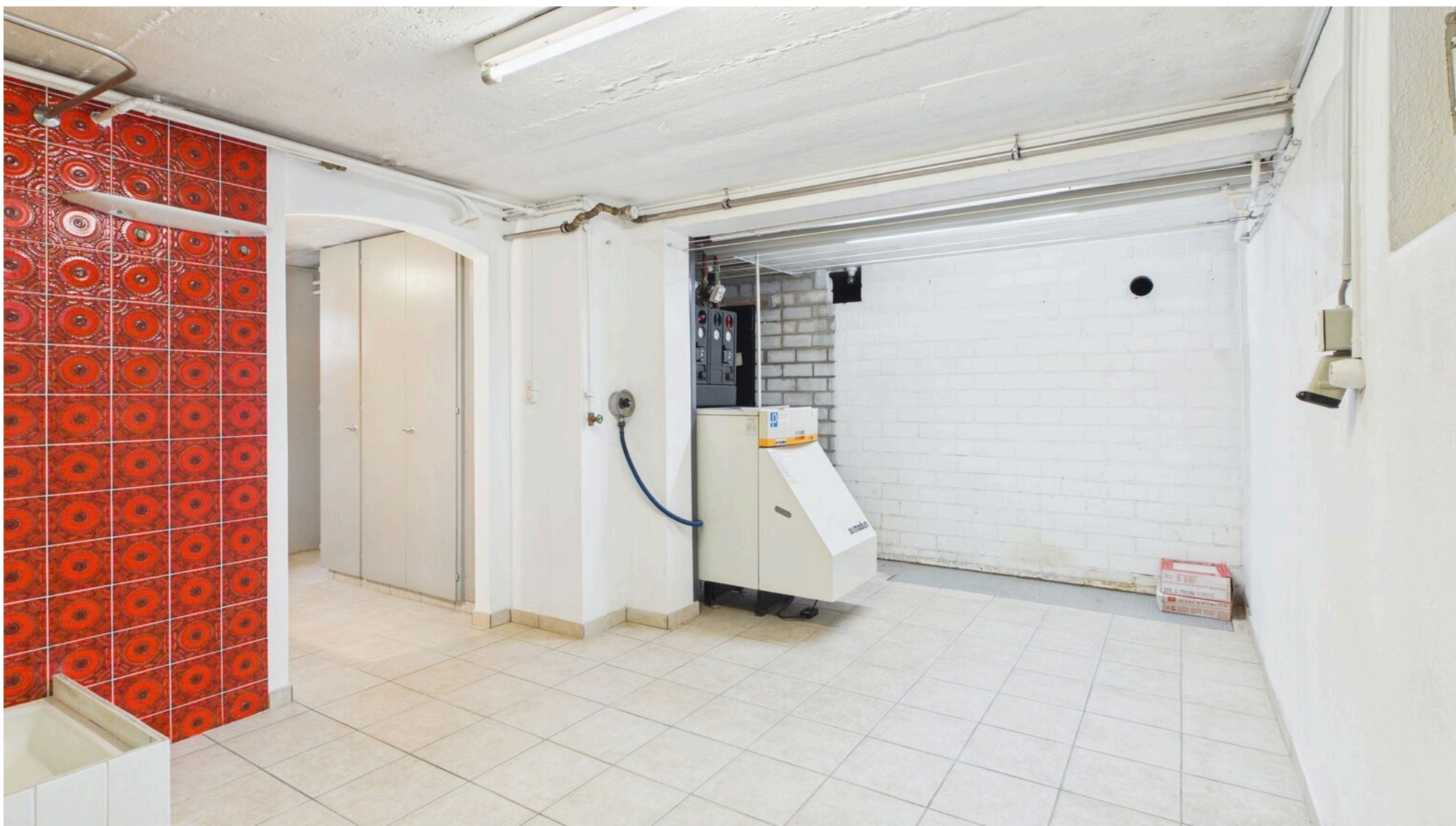
Keller mit Dusche / Heizung UG
